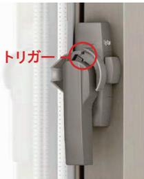
トリガーが受けに押され、ロックが解除されると、クレセントが回り旋転されます。
